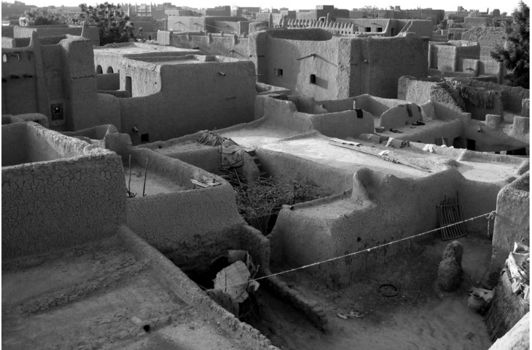
Photo 1: Vue des anciens quartiers de la ville de Djenné montrant l'usage prédominant de la brique de terre crue ( banco ) dans la construction traditionnelle
